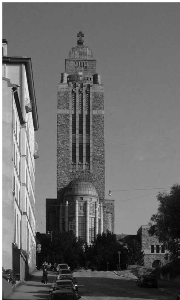
Церковь Каллио, южный фасад (Хельсинки, ул. Итиянен Папинкату, 2). 1908–1912
