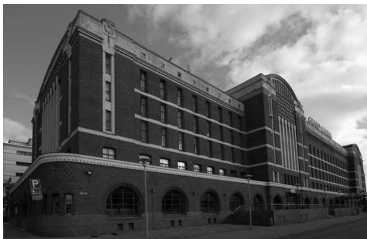
Отель «Grand Marina» (бывший портовый склад) (Хельсинки, ул. Канавакату, 8). 1912, 1927–1928
